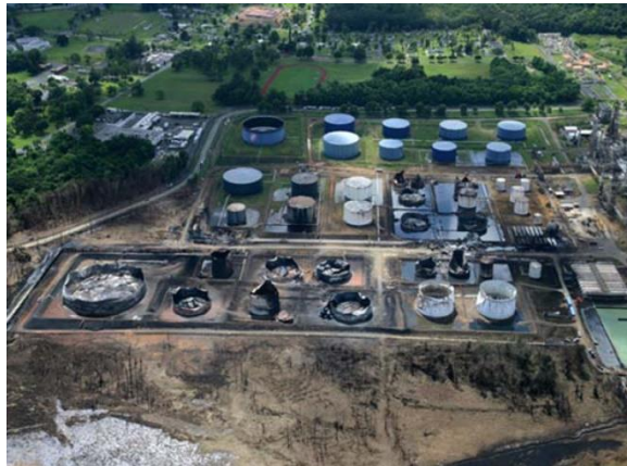
火災後の施設の被害状況
