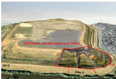
図 1. 貯留池セル2の西北端の崩壊形態
