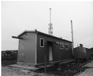
写真 5(d) ボイラーモジュール
