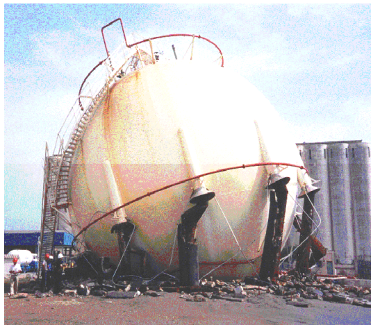
構造材の支柱が腐食
