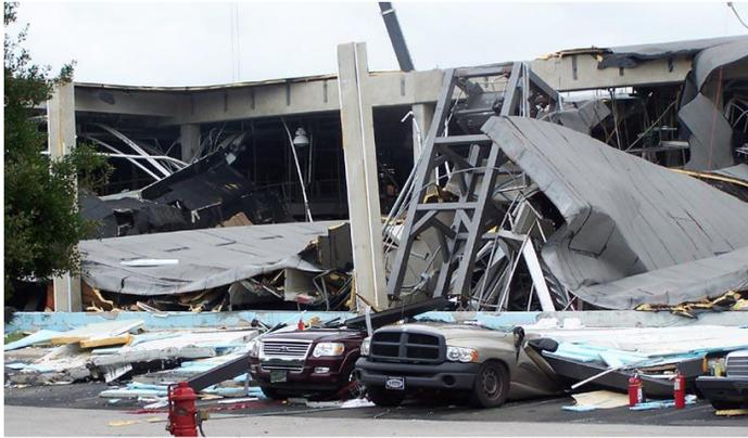
**事故概要** 2009年6月9日、ノースカロライナ州 Garner で、天然ガスの爆発により食肉加工工場が破壊された。工場建屋の一部が倒壊した際、従業員3名が死亡した。従業員4名が大やけどを負い、さらに71名が病院に搬送された。消防士3名が、工場の冷凍システムから漏れた有害な無水アンモニアに曝露された。約 18,000 lbs (8,200 kg) のアンモニアが漏洩し、工場の広い範囲が損傷した。
