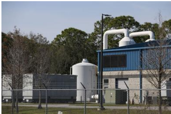
図1. フロリダ州 Oldsmarの水処理プラント
