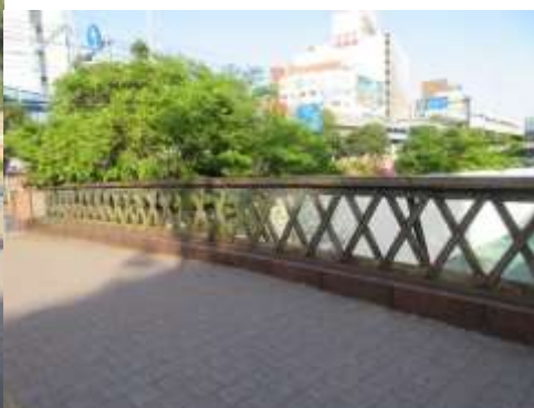
吉田橋 (鉄の橋)
