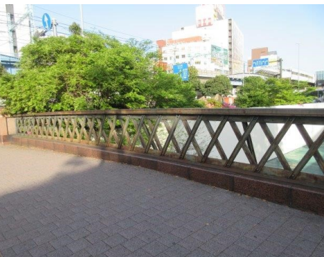
吉田橋(鉄の橋)
