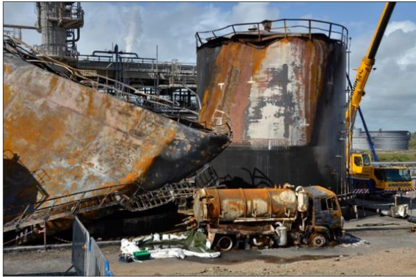
図 1. 爆発・火災の被害状況
