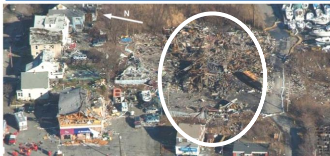
図1. 塗料工場の爆発被害
