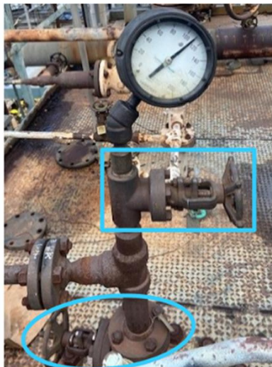
図1. 圧力計を遮断している弁
